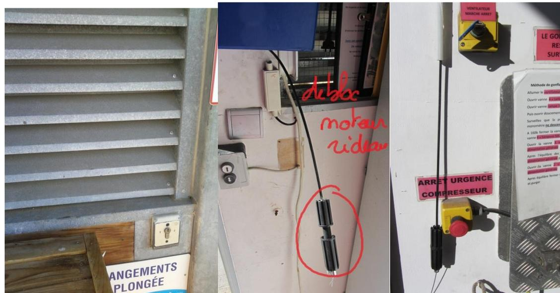
Dévisser la manette noire jusqu'au déclic du mécanisme ce qui débrayera le moteur et permettra de l'actionner manuellement.
