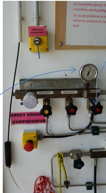
QUAND LE MANOMETRE SE STABILISERA SUR 230B , FERMER LA VANNE + FERMER LES BOUTEILLES ET OUVRIR LA PURGE POUR DEBRANCHER LES BOUTEILLES.
